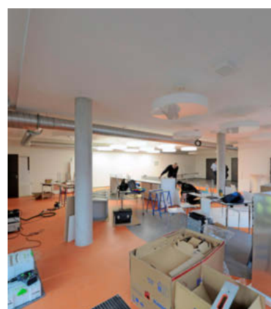
Im Lounge-Bereich sind derzeit noch die Handwerker zugange.
