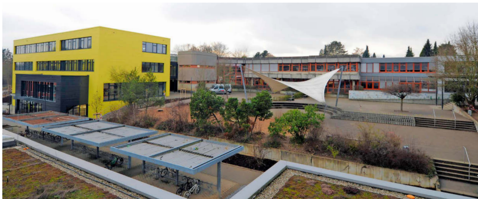
Leuchtend gelb ist der Neubau der Stettenfelschule: Wenn der Altbau saniert ist, werden die beiden Baukörper farblich besser harmonieren.
