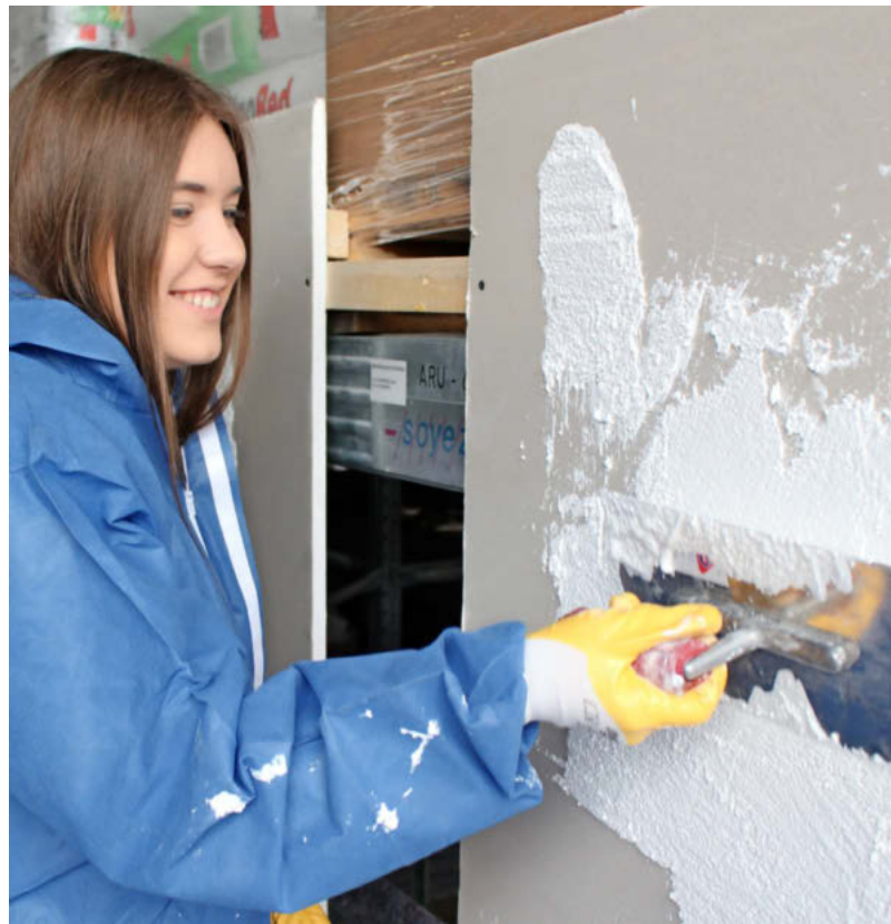
Antonia Haack versucht die Gipskartonplatte zu verputzen. Gar nicht so einfach, da der Putz bröselig ist.
