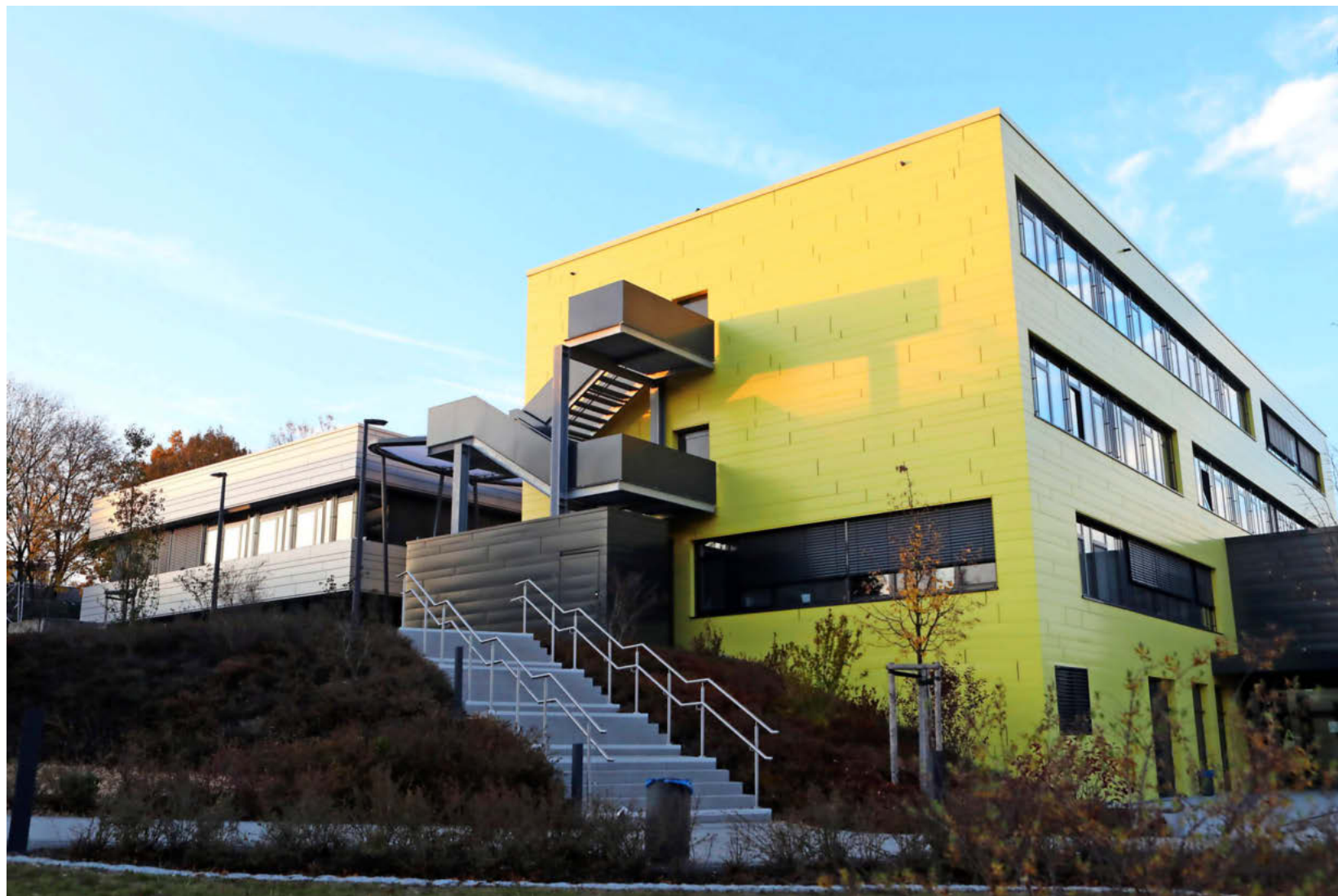
Die Stettenfelsschule hat einen Anbau bekommen. Der Altbau wurde im Anschluss 2017 umfassend saniert.
